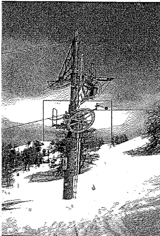
Les téléskis permettent aux skieurs et surfeurs de remonter les pentes enneigées à l'aide de perches amovibles portées et tractées par un câble .
