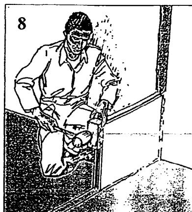
8 Pose du premier carreau.
