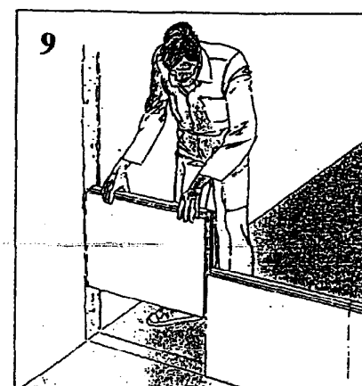
9 Pose du dernier carreau.
