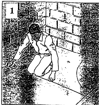
1 Traçage de l'implantation des cloisons.
