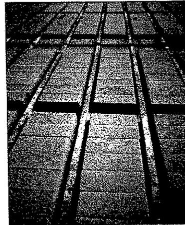
Le plancher PPB ISO 22 peut également être posé en panneaux préassemblés de 2,50 m de large qui rendent la mise en œuvre très rapide du plancher à entrevous.
