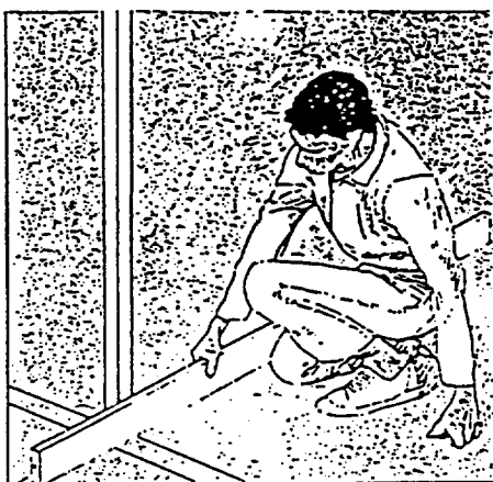
Vérification de la planéité du sol.
