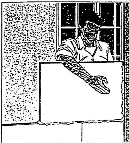
Pose des carreaux suivants.
